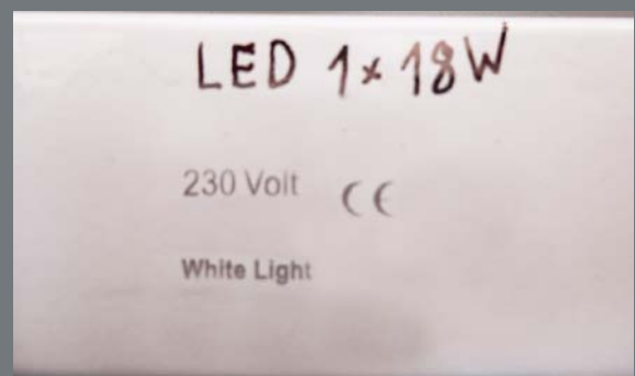
Abb. 4: Handschriftlich abgeändertes Typenschild nach der Umverdrahtung
